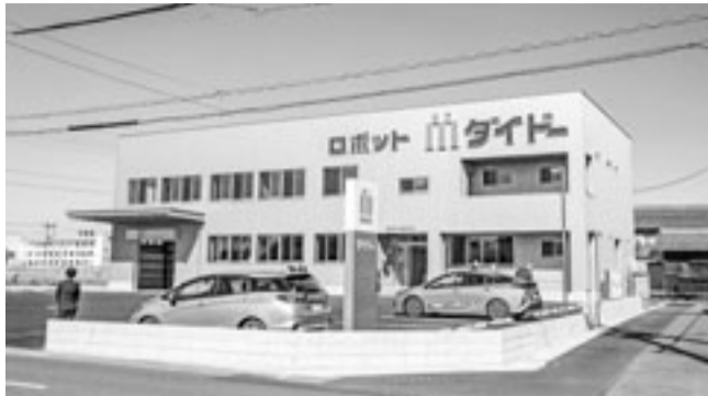
ダイドー岐阜支店外観
